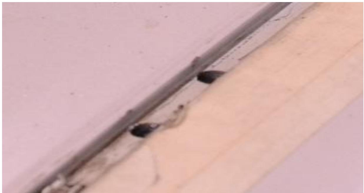
3. Наносим герметик (мы брали шовный) на клепки **позиция 1**, на плоскость которая будет прилегать к крыше, чтобы в дальнейшем избежать протечки крыши.
